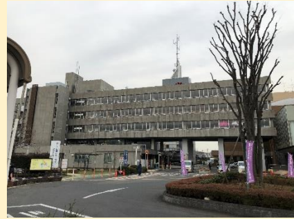
解体される保谷庁舎
